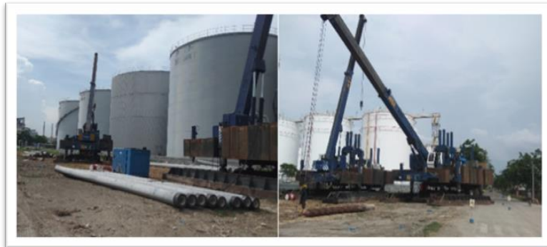
Gambar 4. Aktivitas pemancangan tiang pancang pondasi tangki fame
